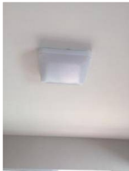
ทำความสะอาดโคมไฟ
