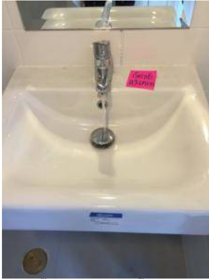
4. ก๊อกน้ำเป็นความ+ก๊อกน้ำไหลไม่แรงให้เช็คอุปกรณ์
