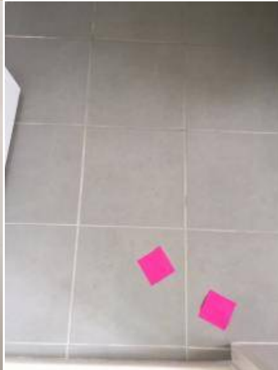
1. ยานแนวพื้นใหม่+กระเบื้องล่อน2แผ่น+เก็บขอบกระเบื้องใหม่+ปูกระเบื้องไม่เต็มแผ่น
