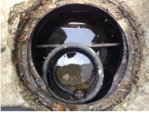
4.ทำความสะอาดบ่อดักไขมันเพราะมีเศษดิน เศษปูน
