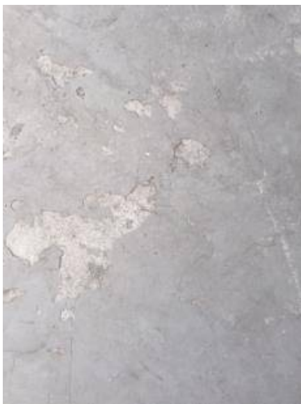
4. งานพื้นโรงรถผิวหน้าปูนกะเทาะ ปรับพื้นใหม่
