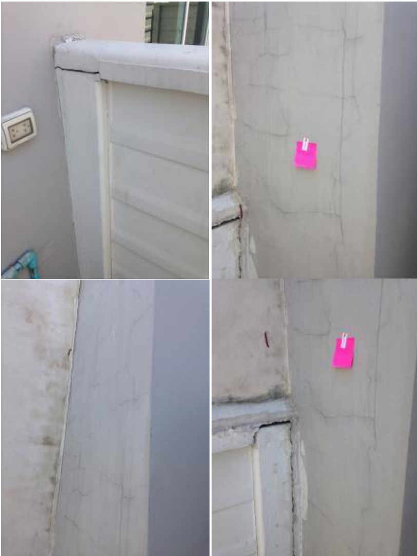
5.ผนังและกำแพงมีรอยแตกร้าว. เก็บสิ่งงานผนังใหม่.
