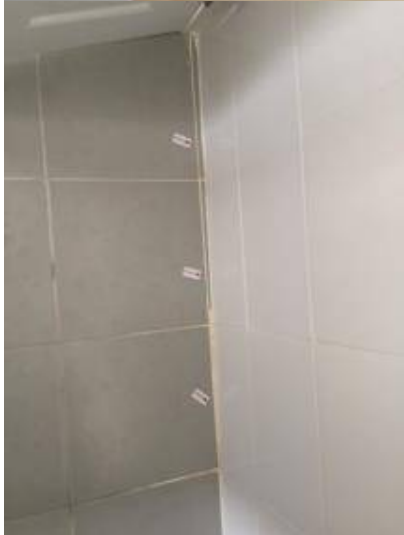
1. ยานแนวพื้นใหม่+กระเบื้องล่อน2แผ่น+เก็บขอบกระเบื้องใหม่+ปูกระเบื้องไม่เต็มแผ่น
