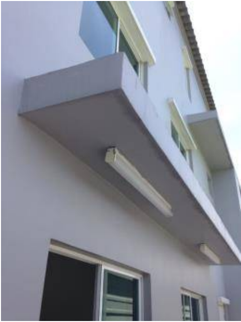
2. ทำความสะอาดหลอดไฟ
