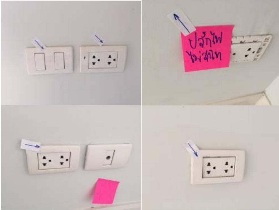
5. ซิลิโคนขอบปลั๊กใหม่ ปลั๊กไฟไม่สนิท เช็คทุกตัว
