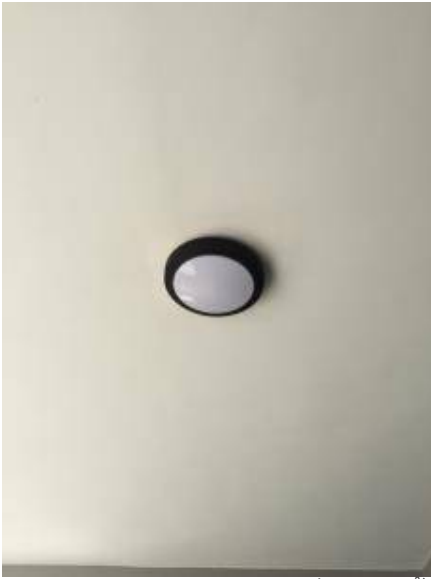
5.ทำความสะอาดคอมไฟ+เปลี่ยนหลอดชั้นสนิม
