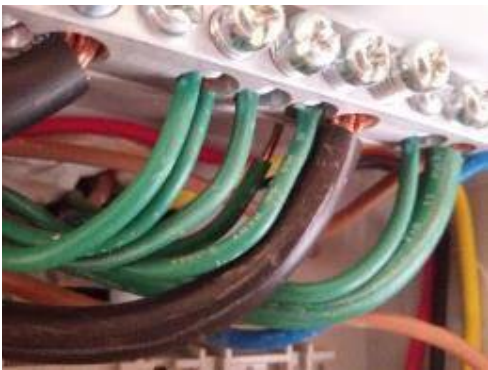
4. ติดสายดินในกล่องไฟให้เรียบร้อย
