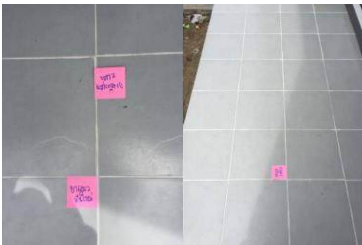
4. ยานแนวพื้นใหม่ทั้งหมด+มีกระเบื้องแตก เปลี่ยนใหม่
