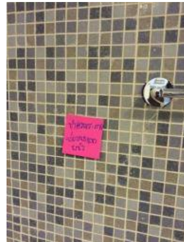
3. ทำความสะอาด+เก็บงานยาแนวกระเบื้องผนัง
