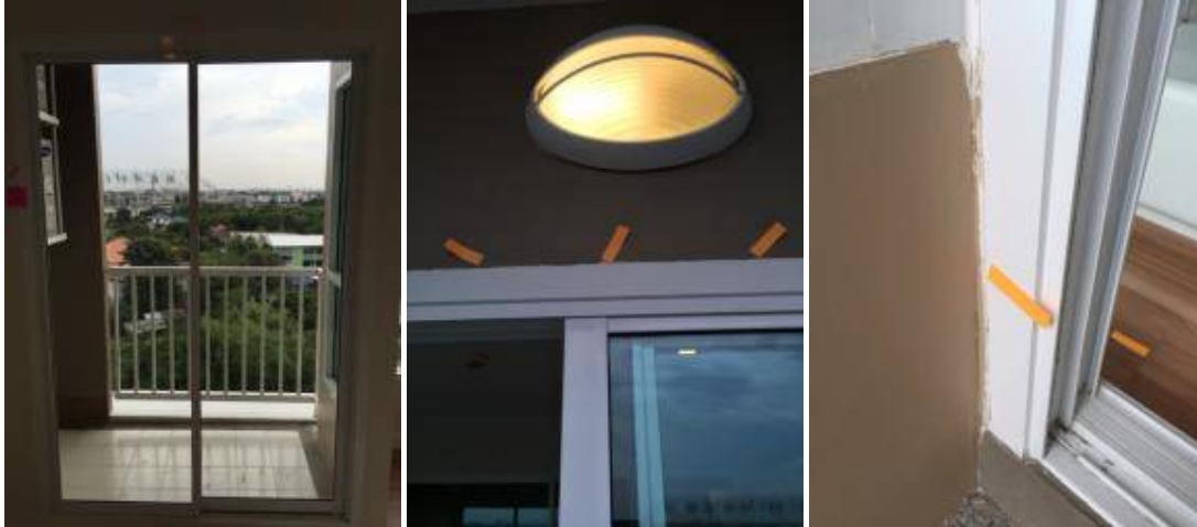
1. เก็บงานขอบเฟรมบานเลื่อน โดยรอบทั้งหมด
